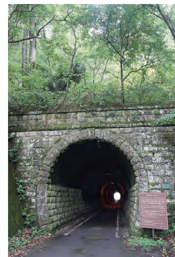
古間駅から線路沿いの道を南へ徒歩5分ほどの旧戸草トンネル。レンガと切石で組まれた長野県最古の鉄道用トンネルで、今は町道として利用されている
